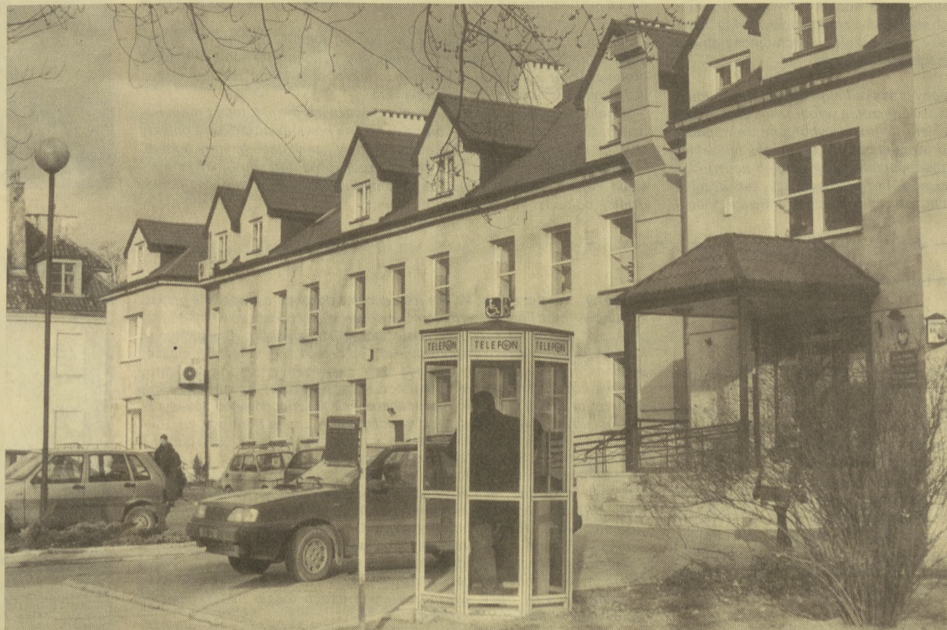
Siedziba Urzędu Gminy przy ul. Przybyszewskiego 70/72
