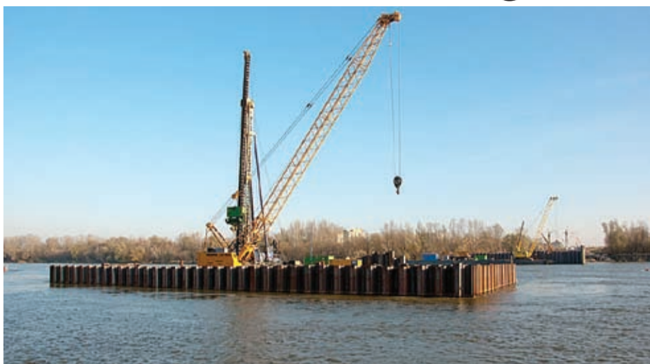
Ścianki szczelne w nurcie Wisły
