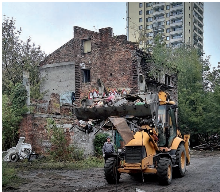
Rozbiórka pustostanu przy ul. Godowskiej
