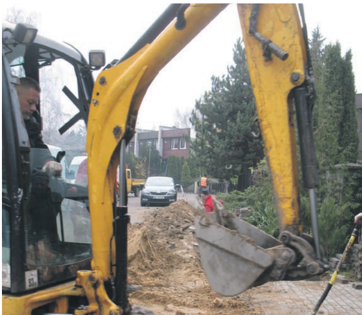
Remont ul. Parandowskiego
