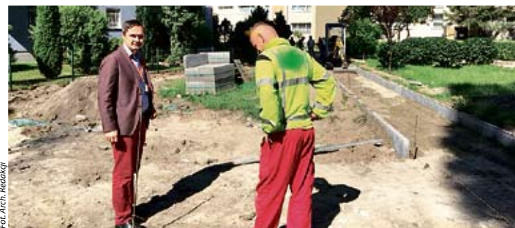
Włodzimierz Piątkowski na miejscu remontu nowego bielańskiego podwórka
