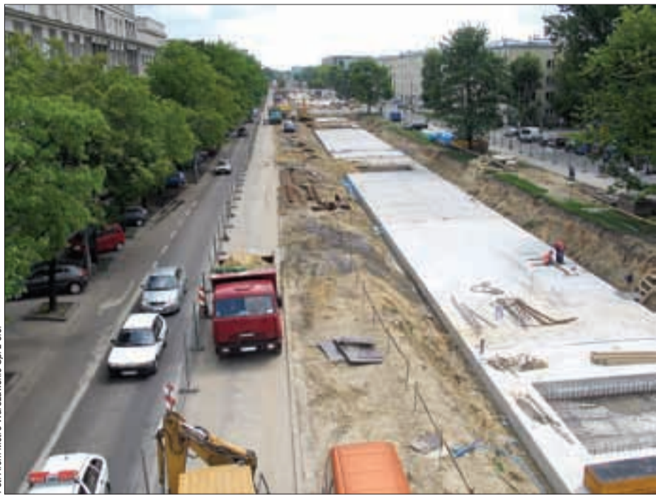
Budowa tuneli metra na ul. Kasprowicza
