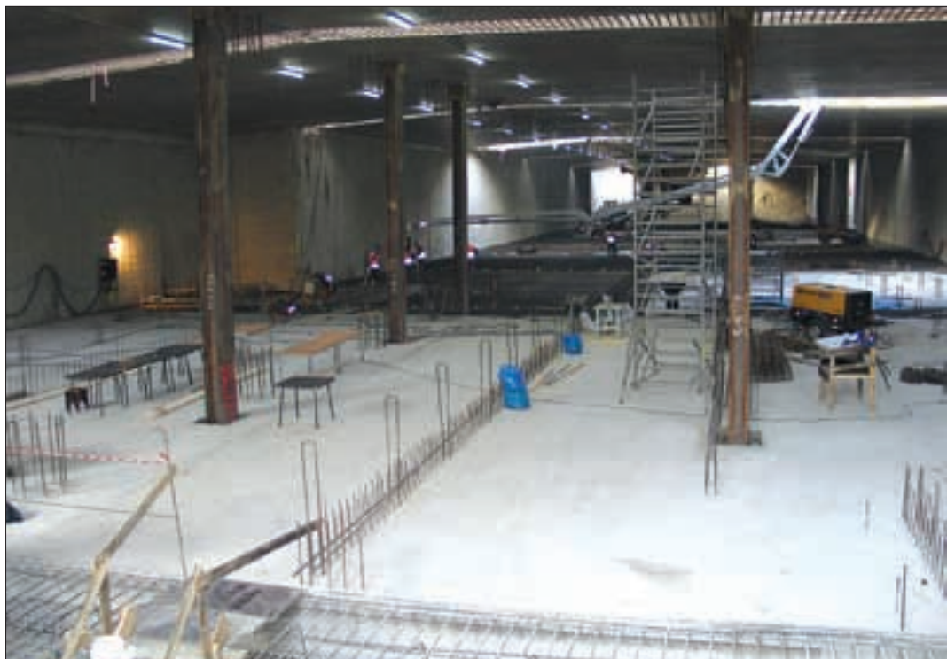
Budowa na Stacji Słodowiec
