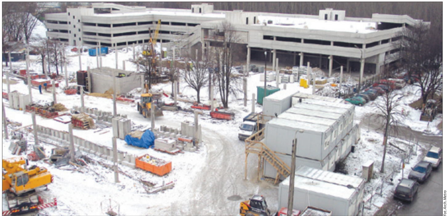
Budowa nowego parkingu przed stacją Młociny
