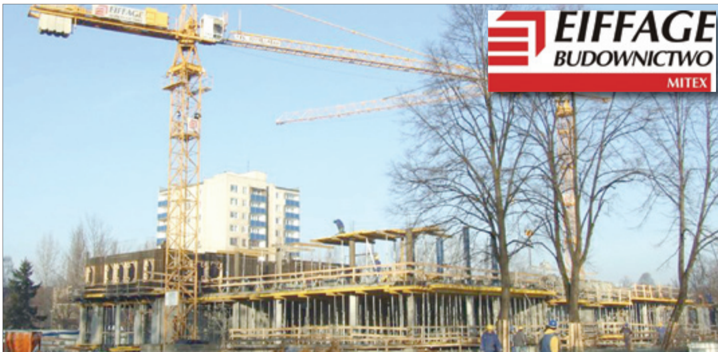
Ratusz w budowie
