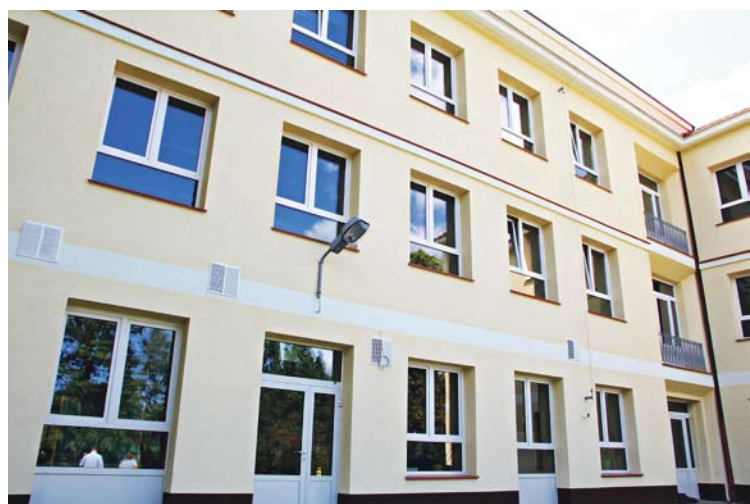
Budynek ZS nr 35 po remoncie
