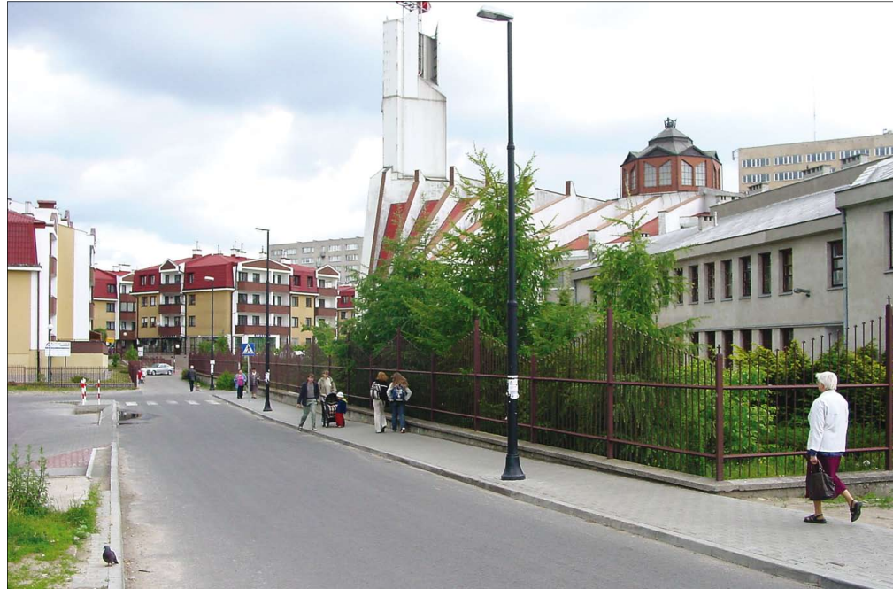
Ciąg pieszojezdny w rejonie ul. Przy Agorze i Wrzeciono
