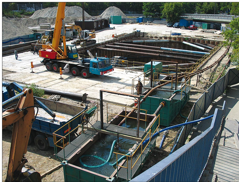
Budowa tunelu szlakowego (B20), prowadzącego od stacji Marymont (A19) do stacji Słodowiec (A20)
