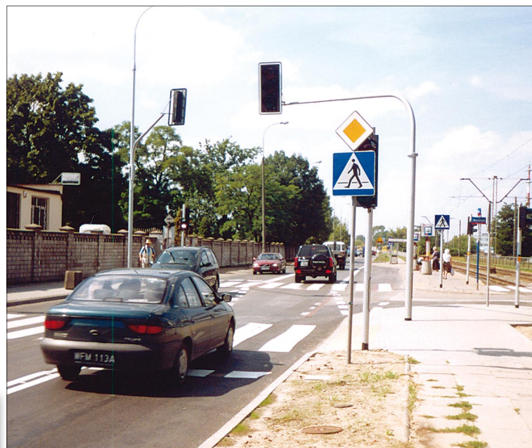
Nowa sygnalizacja świetlna na ul. Wólczyńskiej
