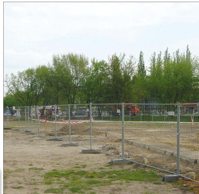
Przyszły plac budowy metra na Marymoncie
