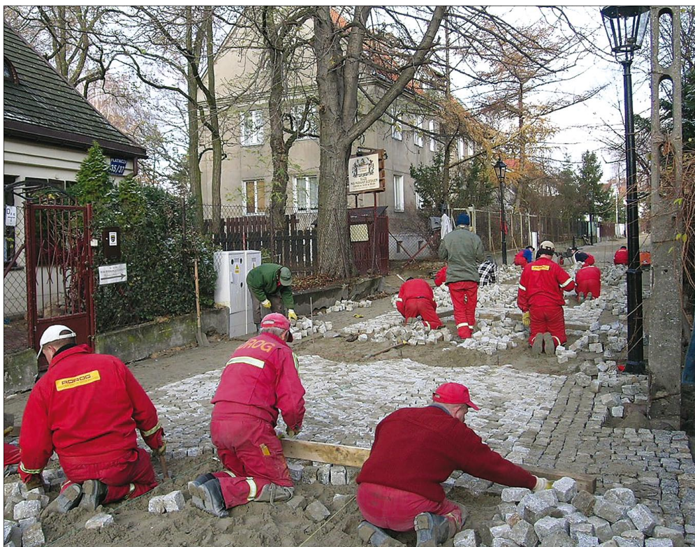
Przebudowa ul. Płanicy na odcinku od Schroegera do Żeromskiego
