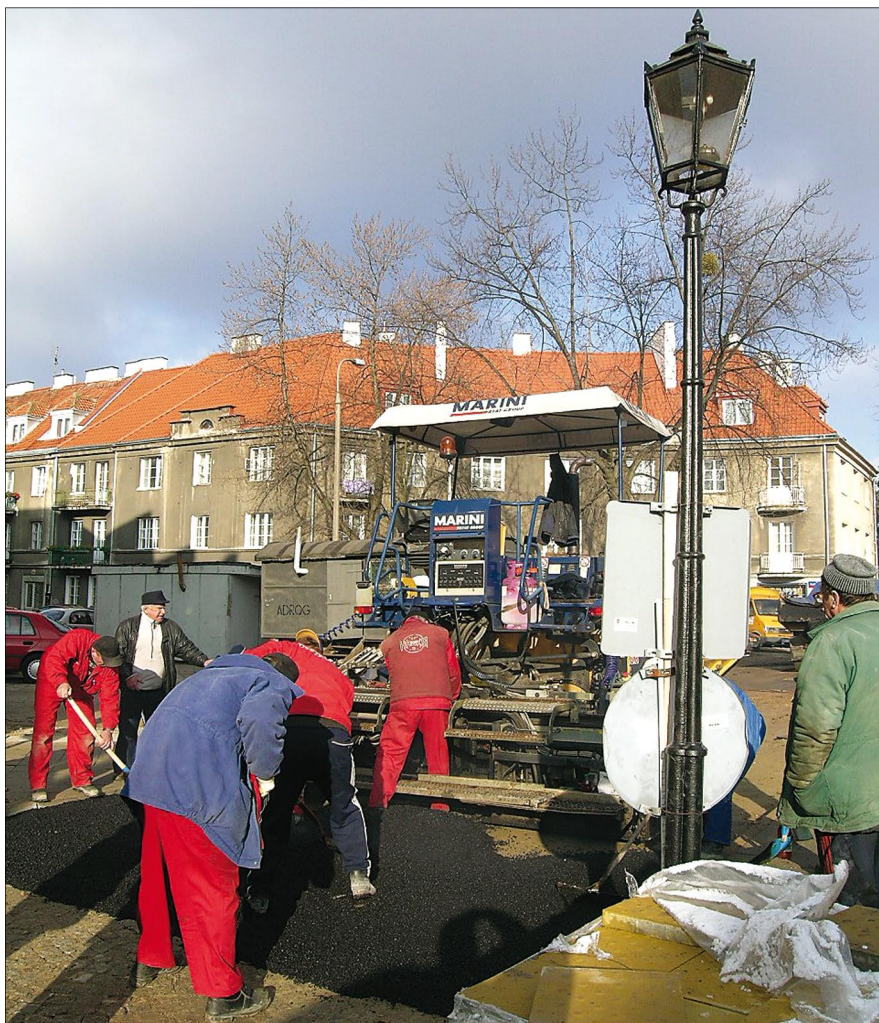
Przebudowa ul. Piatniczej na odcinku od Schroegera do Żeromskiego
