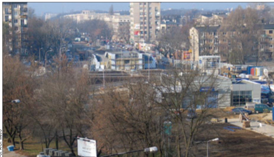
Pawilony stacji Słodowiec
