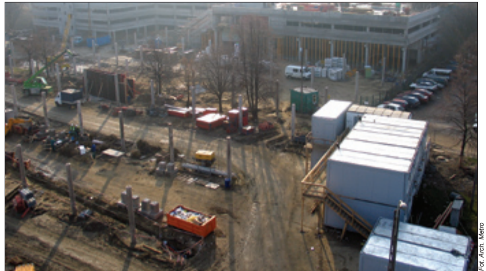
Teren węzła Młociny z bryłą parkingu
