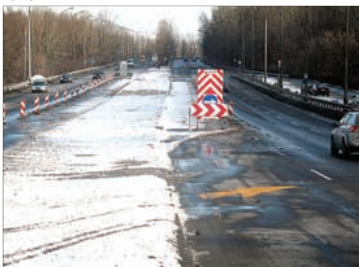
Odcinek Wybrzeża Gdyni przygotowany do remontu
