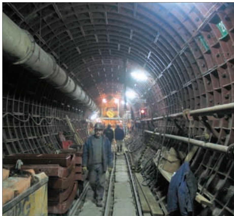
Budowa metra pod Trasą AK
