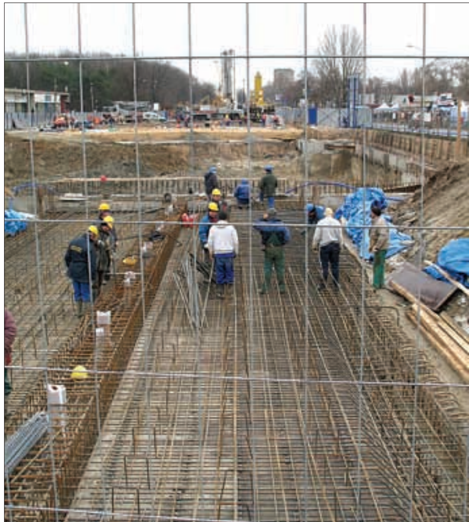
Budowa metra na ul. Kasprowicza
