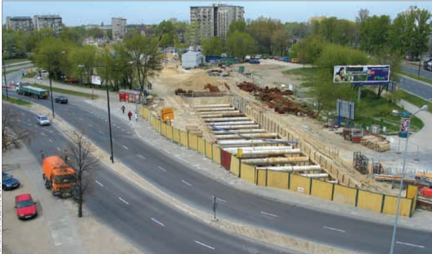
Skrzyżowanie ulic Marymonckiej i Żeromskiego. Widok na rozparcie wykopu szlaku B20 w kierunku stacji Słodowiec. Na tym odcinku szlak jest budowany metodą odkrywkową, czyli po wybudowaniu ścian szczelinowych, prowadzony jest wykop, który umożliwi kładzenie płyty dennej, a dopiero na końcu budowany jest strop. Przypomnijmy, że sama stacja Słodowiec budowana jest metodą odkrywkową stropową.
