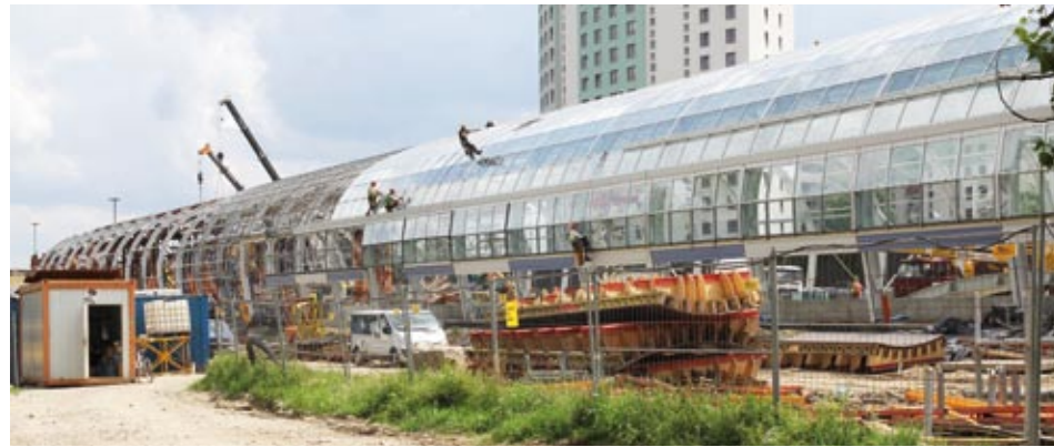
Półtunnelowe ekrany akustyczne przy Trasie AK
