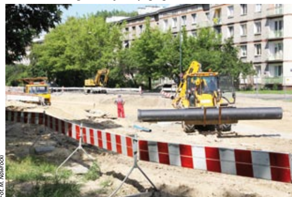
Prace przy budowie al. Reymonta
